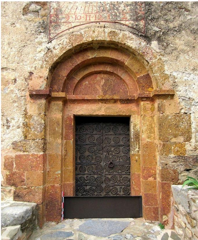
Fig. 2. Exemple de portail en pierre bréchique rouge foncé, Notre-Dame de Mercadal à Castelnuou. Certaines pierres procèdent d'une restauration récente avec des matériaux aux propriétés comparables.
