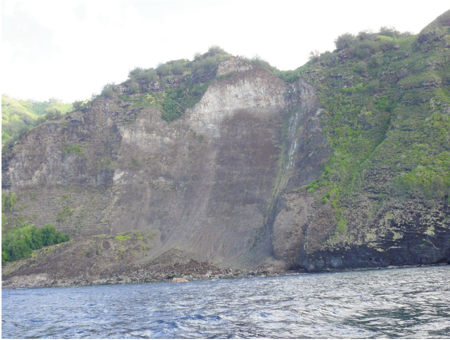
Photo 8 - Eboulement de la falaise côtière du bouclier du Touaouoho dans la baie de Vai Faite au Sud de Fatu Hiva. Il se produisit le 13/09/1999 et déclencha un petit tsunami. Photo G. Guille.
