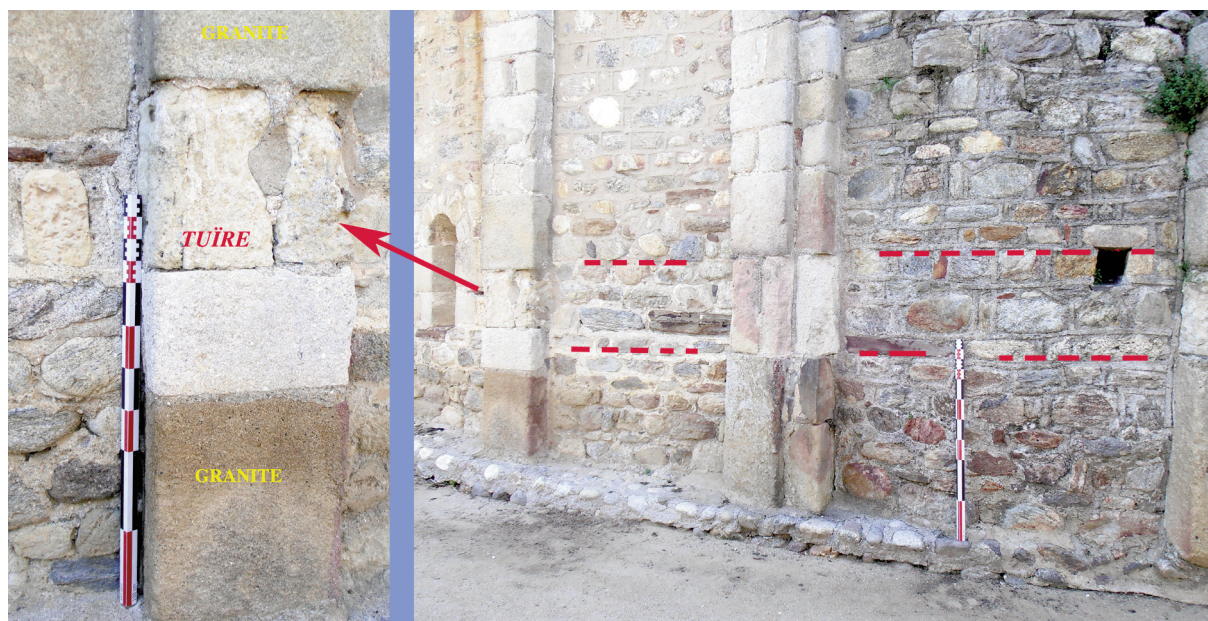
Figure 14 - Cathédrale Sainte-Julie et Sainte-Eulalie (Elne - 66). Sur la vue de l'abside édifiée au XI e siècle, apparaissent quelques blocs de tuïre sur toutes les lesènes en granit. Placées bien en vue à un mètre du sol, cette roche occupe ici une position anormale dans le bâti, très probablement pour rappeler le matériau qui formait l'essentiel des parties ouvragées de l'église antérieure. De nombreux autres exemples peuvent être cités en Roussillon de tuïres massivement utilisés dans les églises primitives dont on retrouve quelques exemplaires bien exposés dans les absides rénovées aux XI e et XII e siècles pour témoigner d'une continuité du lieu sacré (© Cécile Respaut).
